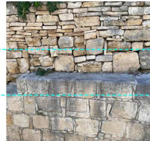
τοιχοποιία με οριζόντια διάταξη διαφορετικού μεγέθους λίθων με πλακοειδής μορφή (χρήση ραμμάτων)
