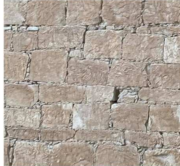
τοιχοποιία με χρήση ίδιου μεγέθους λίθων με τη χρήση χαλικώματος για αρμούς
